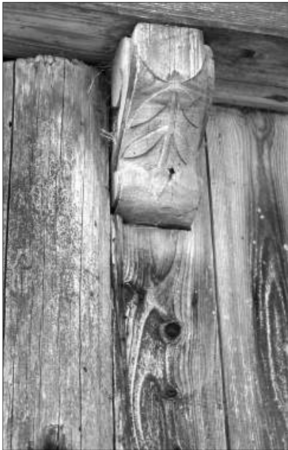
Stubos išilginės sienos iškyša – konsolė, remianti skydą. Naudžių k. Vilkaviškio r. I.Kačinskaitės 2007 m. nuotr.
