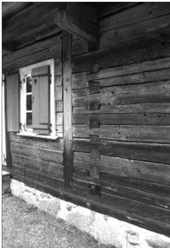
Sienojų sujungimui naudojama švilinė stulpinė konstrukcija
