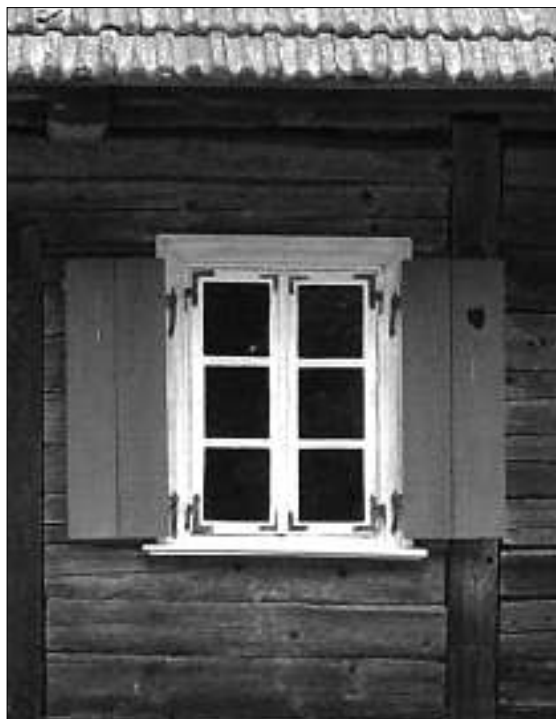
Langas su profiliuoto medžio apylangėmis be ryškesnių dekoru elementų. Langinės – paprastos, sukaltos iš vertikalų lentų. Obelinės k. Marijampolės r. LLBM
