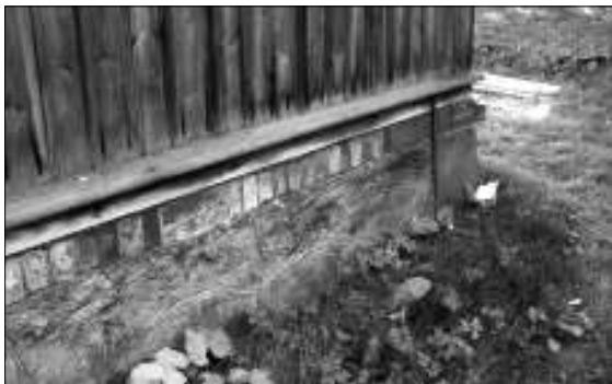
Stubų viršutinė pamato dalis – cokolis dažnai mūrijama iš skelto akmenų mūro, virš kurio dedama plytų mūro eilė
