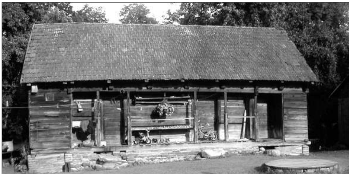
Klėtis su prieklėčiu, kurioje ne tik šoninės klėties sienos, bet ir siauros šoninės patalpos – „antai“ – pratęsimos per visą prieklėčio plotį. Naudžių k. Vilkaviškio r. D.Ambrasaitės 2005 m. nuotr. VKM
