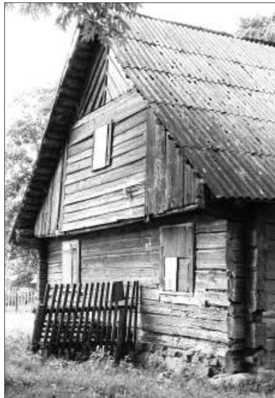
Stoboms būdingas nuo sienos plokštumos atitrauktas pastogės skydas
