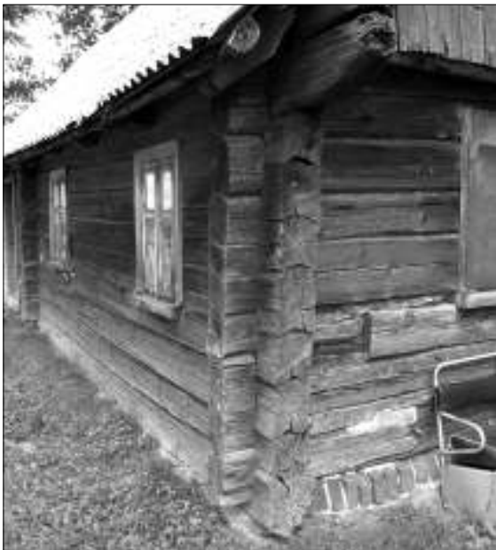
Stubų viršutinė pamato dalis – cokolis dažnai mūrijama iš skelto akmenų mūro, virš kurio dedama plytų mūro eilė
