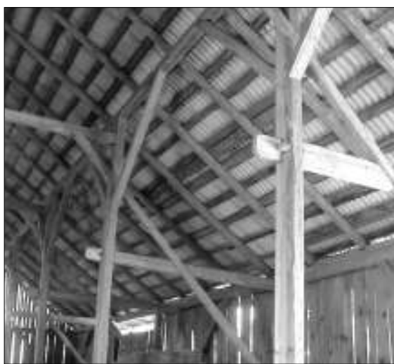
Stulpinės konstrukcijos kluono vidaus vaizdas. Starkų k. Vilkaviškio r. D.Ambrasaitės 2005 m. nuotr. VKM
