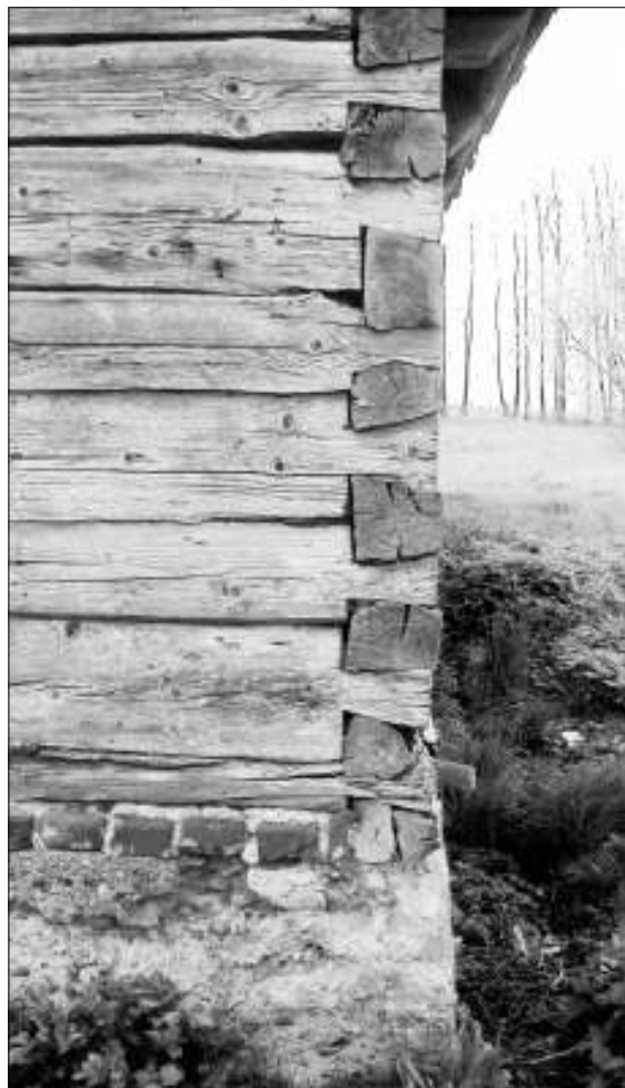
Stubos renčiamos iš horizontalių pjautų rąstų, sudėtų vienas ant kito ir sunertų kampuose į kertes arba į sąsparas
