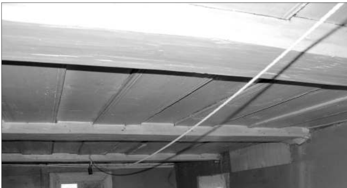
Vožtinės lubos įleistos į dalį balkių šeimynstubėje. Lubų lentos puošiamos griovelio formos ornamentais. Mieleiškampio k. Prienų r. I.Kačinskaitės 2007 m. nuotr.
