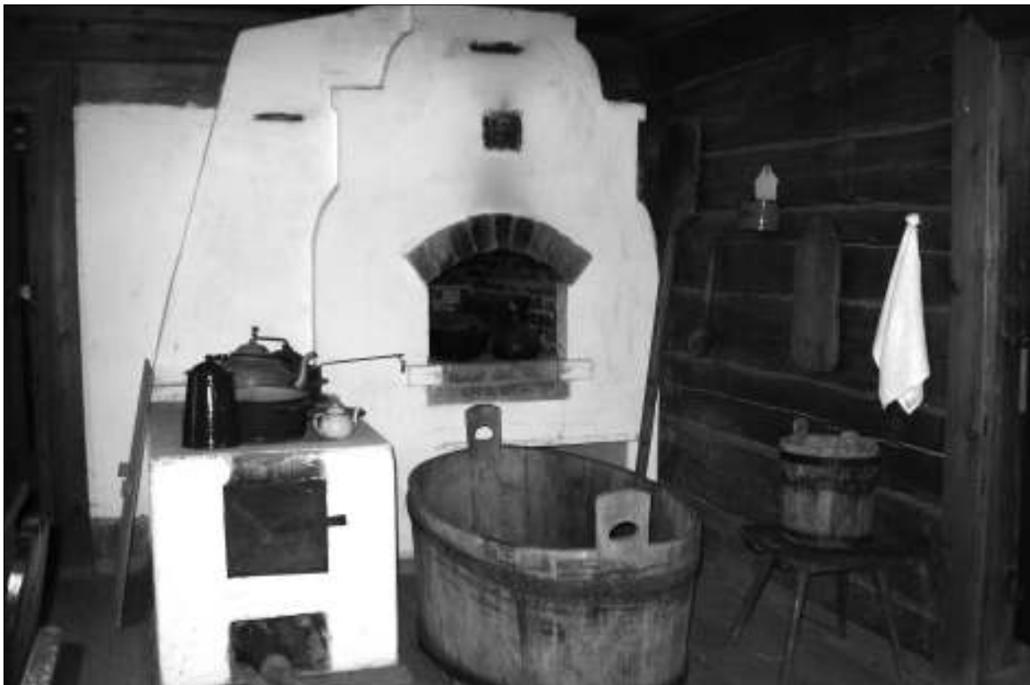
Virtuvėje įrengiama duonkepimo, vadinamo pečiūmis, pakura, o korpusas stuboje (šeimynstubėje), kurią apšildo. LLBM
